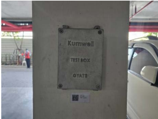
ภาพที่ 2-24 ระบบสายดิน
