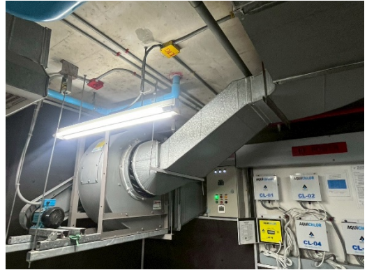
ภาพที่ 2-5 พัดลมระบายอากาศ
