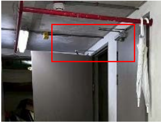
ภาพที่ 2-32 กลไกการปิดประตูอัตโนมัติ
