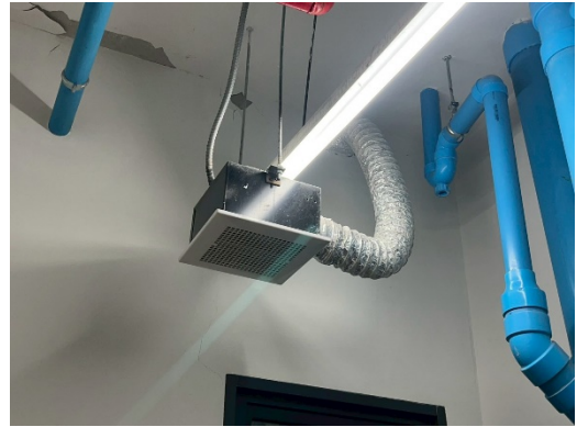
ภาพที่ 2-33 พัดลมดูดอากาศในห้องพักขยะ
