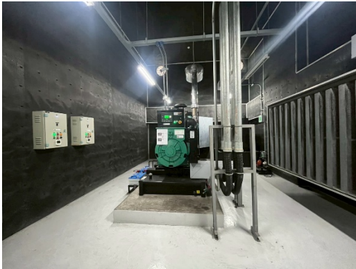
เครื่องกำเนิดไฟฟ้าสำรอง (Generator)
