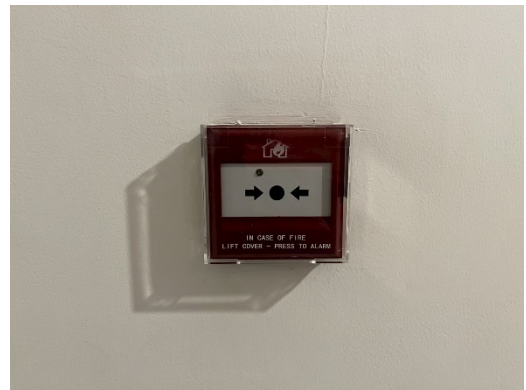
อุปกรณ์แจ้งเหตุด้วยมือ (Manual Call-Point)
